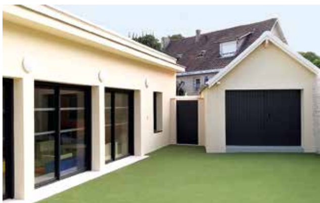
La nouvelle crèche, prête à accueillir les enfants. PHOTO : FD
